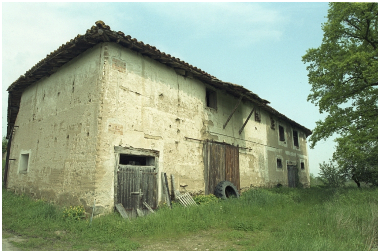
Premier ensemble. Bâtiment sud-est : vue d'ensemble depuis le sud.
