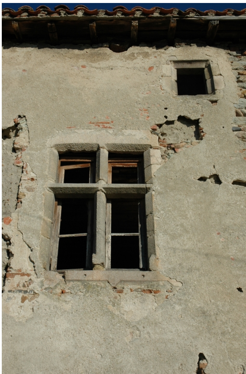
Détail d'une fenêtre du logis, élévation sud, 1er étage.
