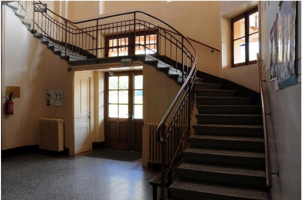
Escalier, corps central
