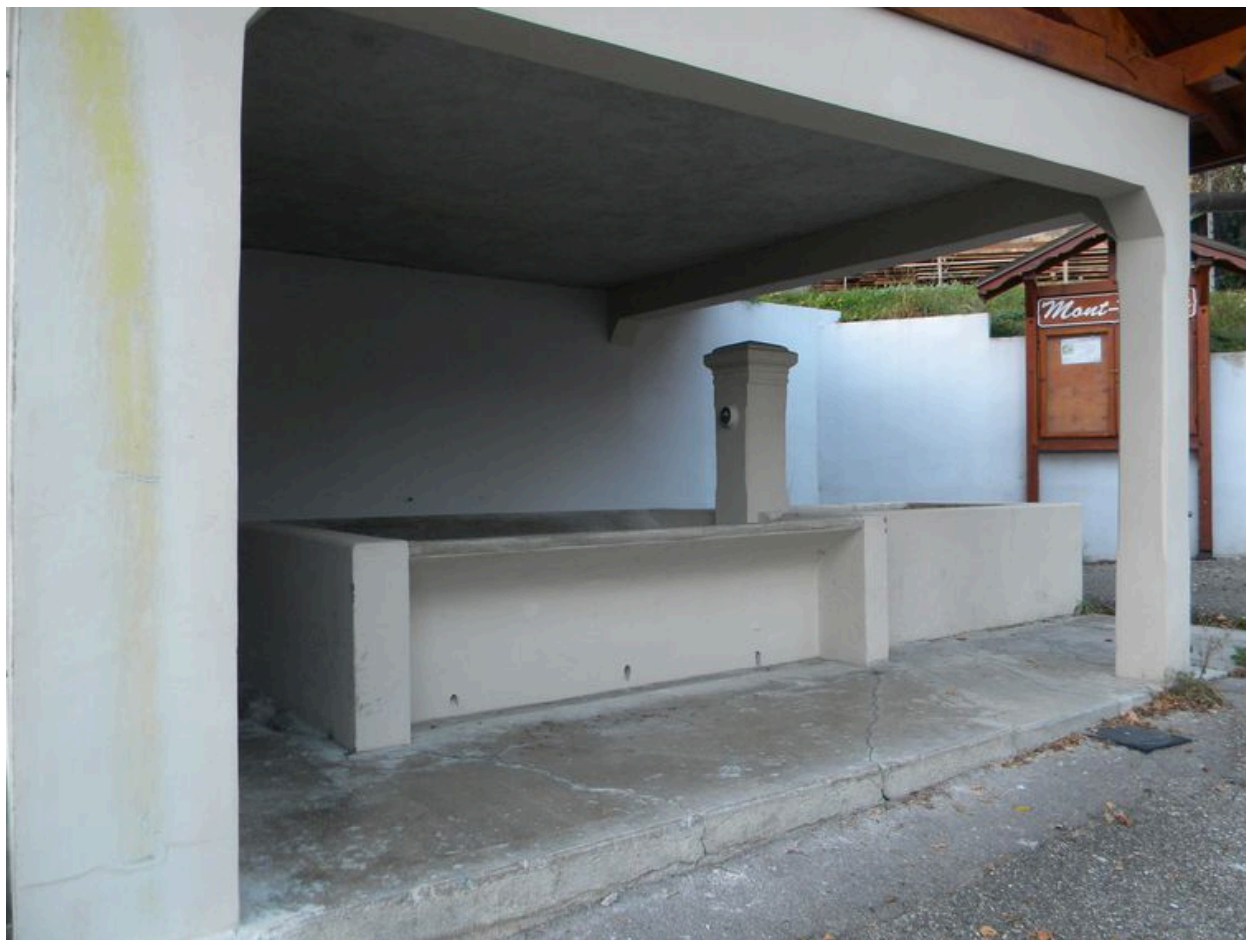
Vue générale du lavoir couvert.
