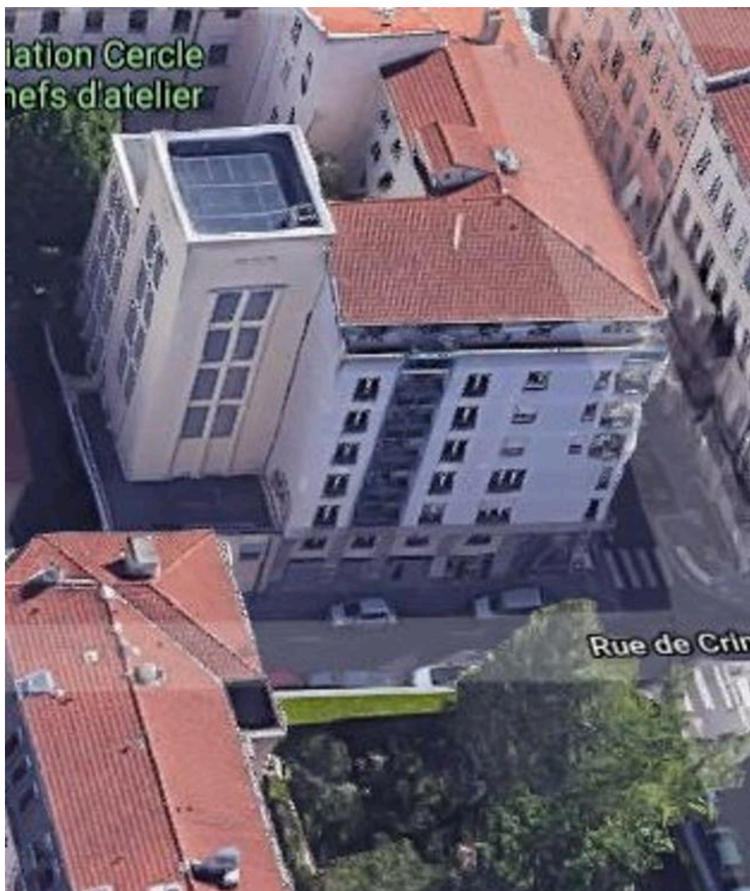
Vue Google de l'usine de ventilation n° 4
