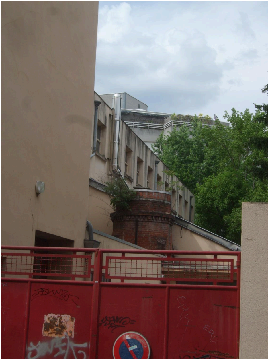
Embase de cheminée en brique et aile des bains-douches
