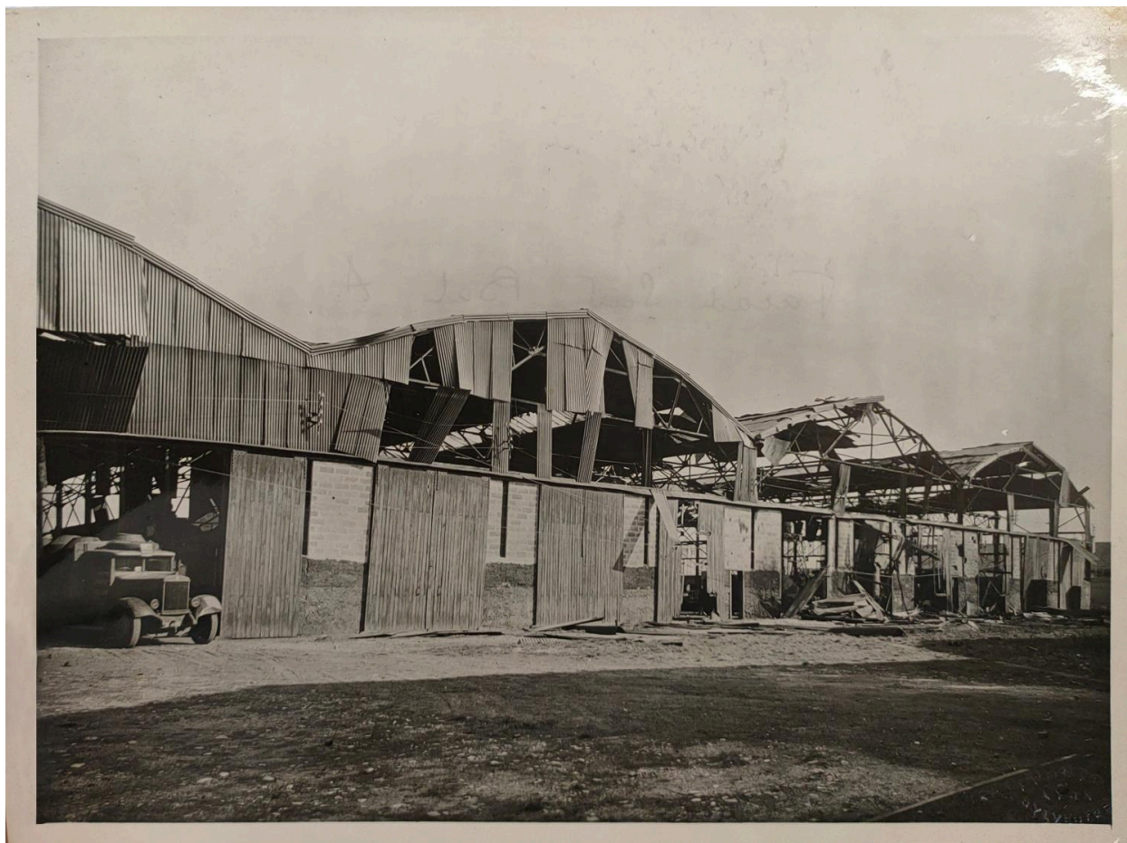
Façade Sud bâtiment A - Photo extraite des dossiers de dommages de guerre - 1948 (AD Rhône)
