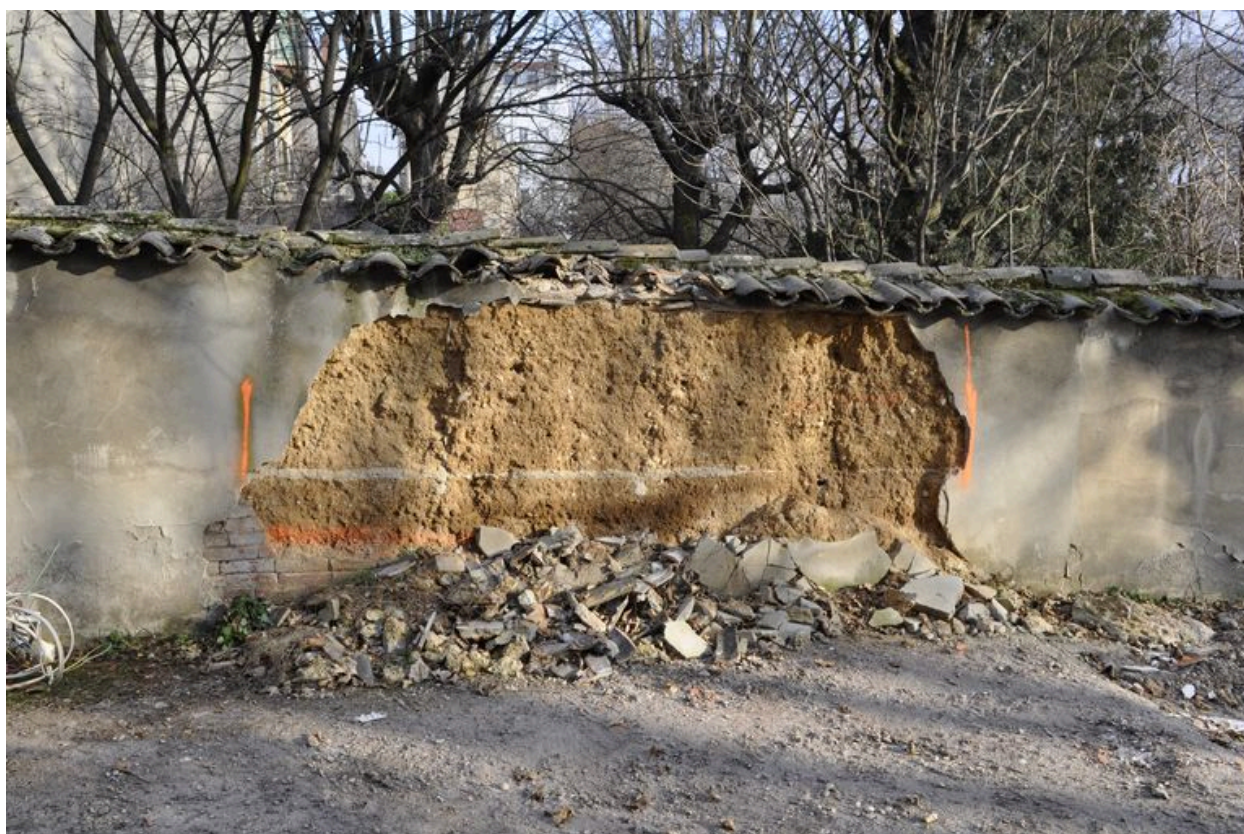
Détail du mur de clôture est.
