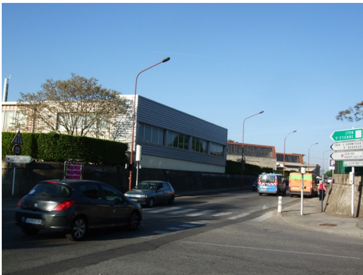
Vue générale nord, toiture shed
