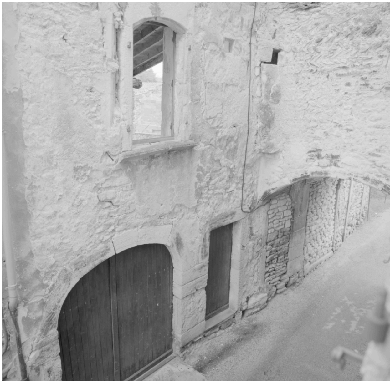
Corps de passage sur la rue des Fontaines, faisant partie de la maison.
