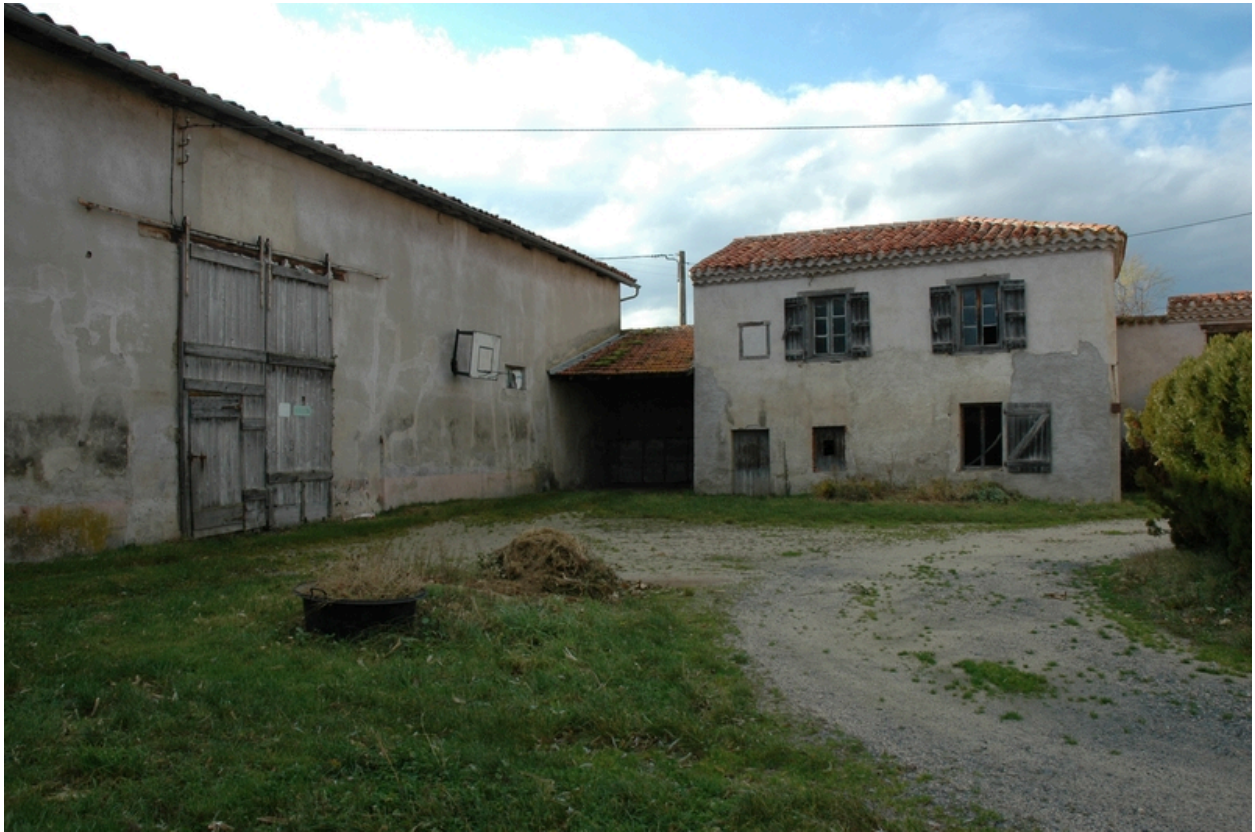
Vue intérieure de la cour, depuis le nord-est : fournil, hangar, grange-étable.
