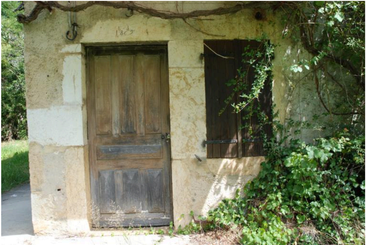
Détail de la porte d'accès du logis de la parcelle 483.
