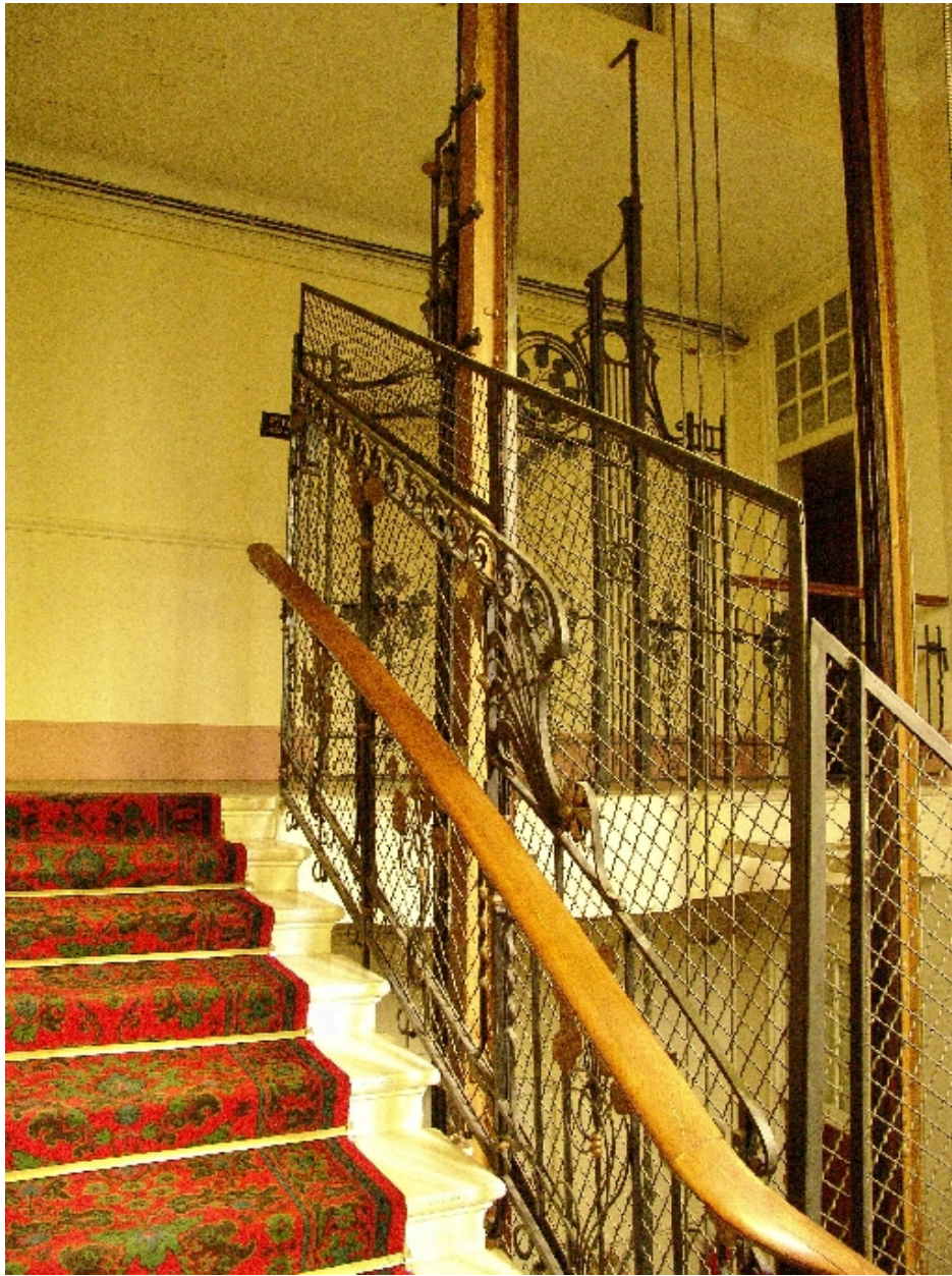
Garde-corps de la cage d'ascenseur
