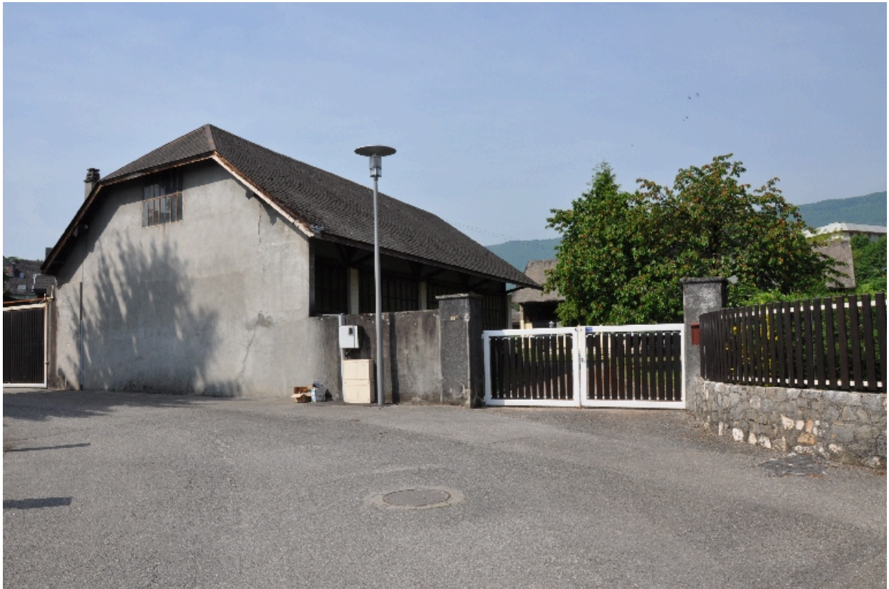
Vue de l'ancienne ébénisterie depuis la rue Docteur Gasca
