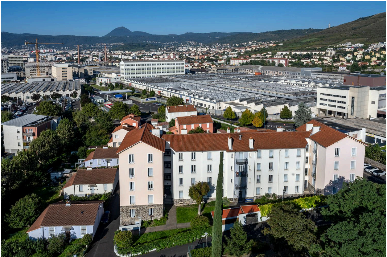
Vue aérienne partielle de la cité ouvrière et de l'immeuble collectif.
