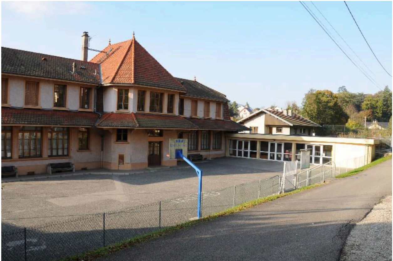
Cour, école primaire (à gauche) et cantine (à droite)
