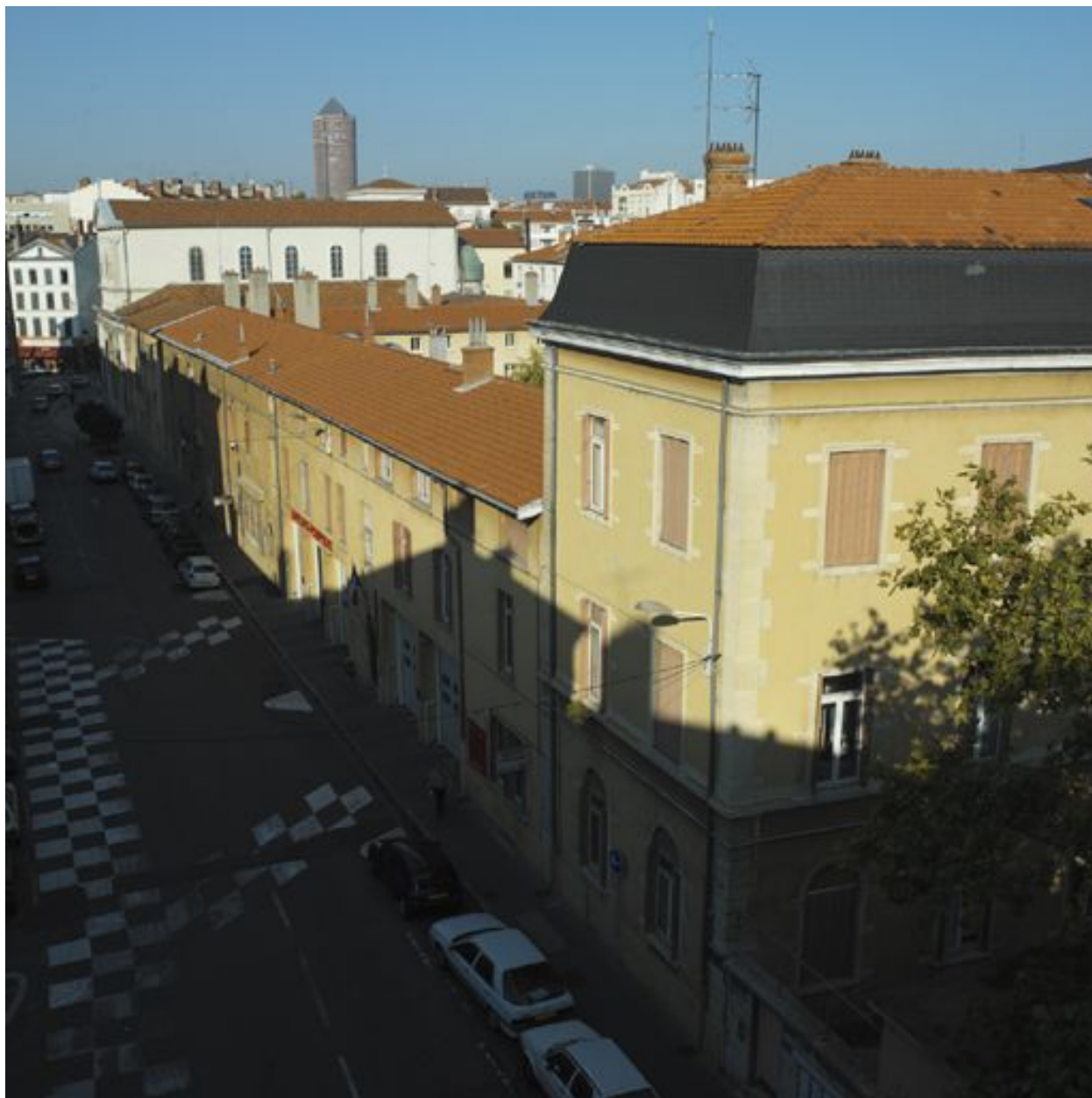
Vue des bâtiments rue de la Madeleine depuis le sud-ouest
