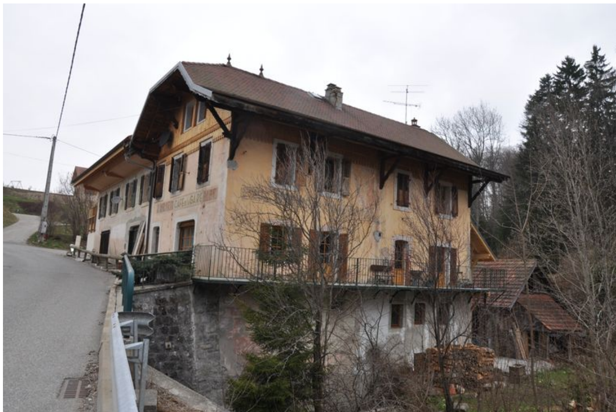
Façade latérale sud du bâtiment du moulin où se trouvaient les anciennes roues
