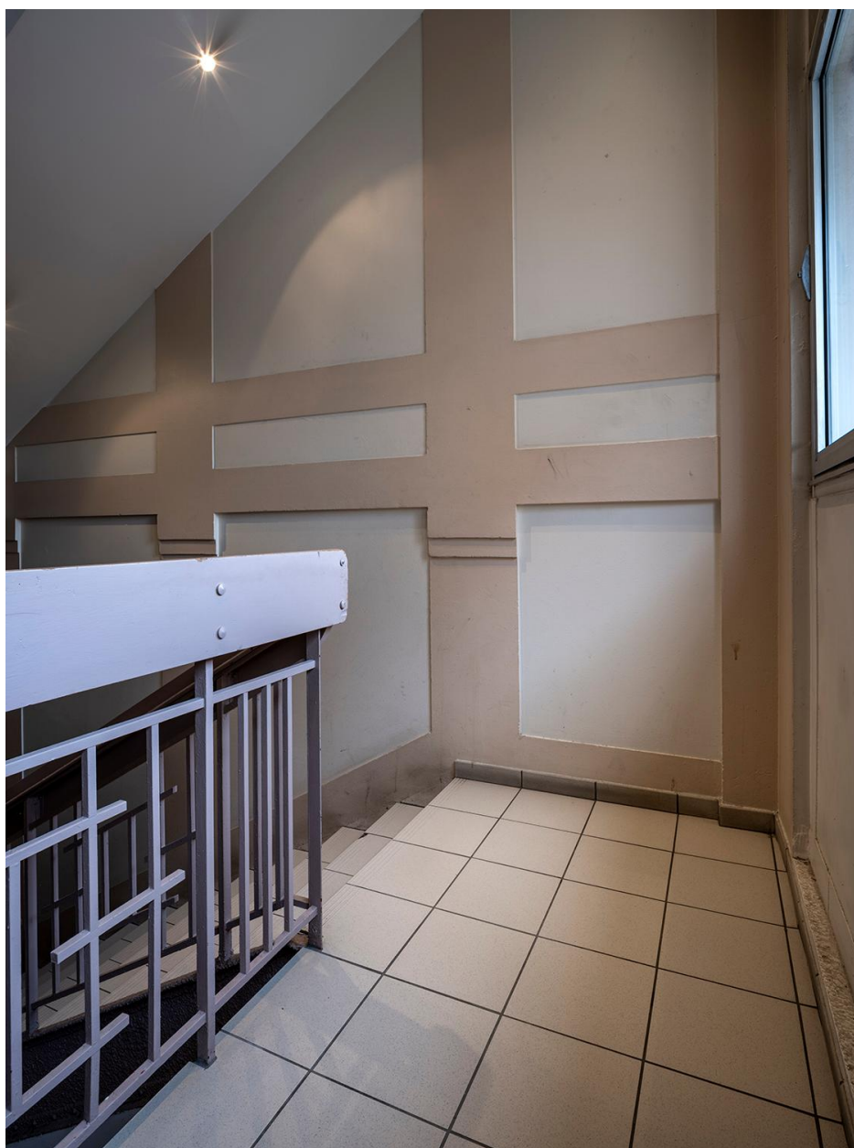
Détail montée d'escalier très soignée
