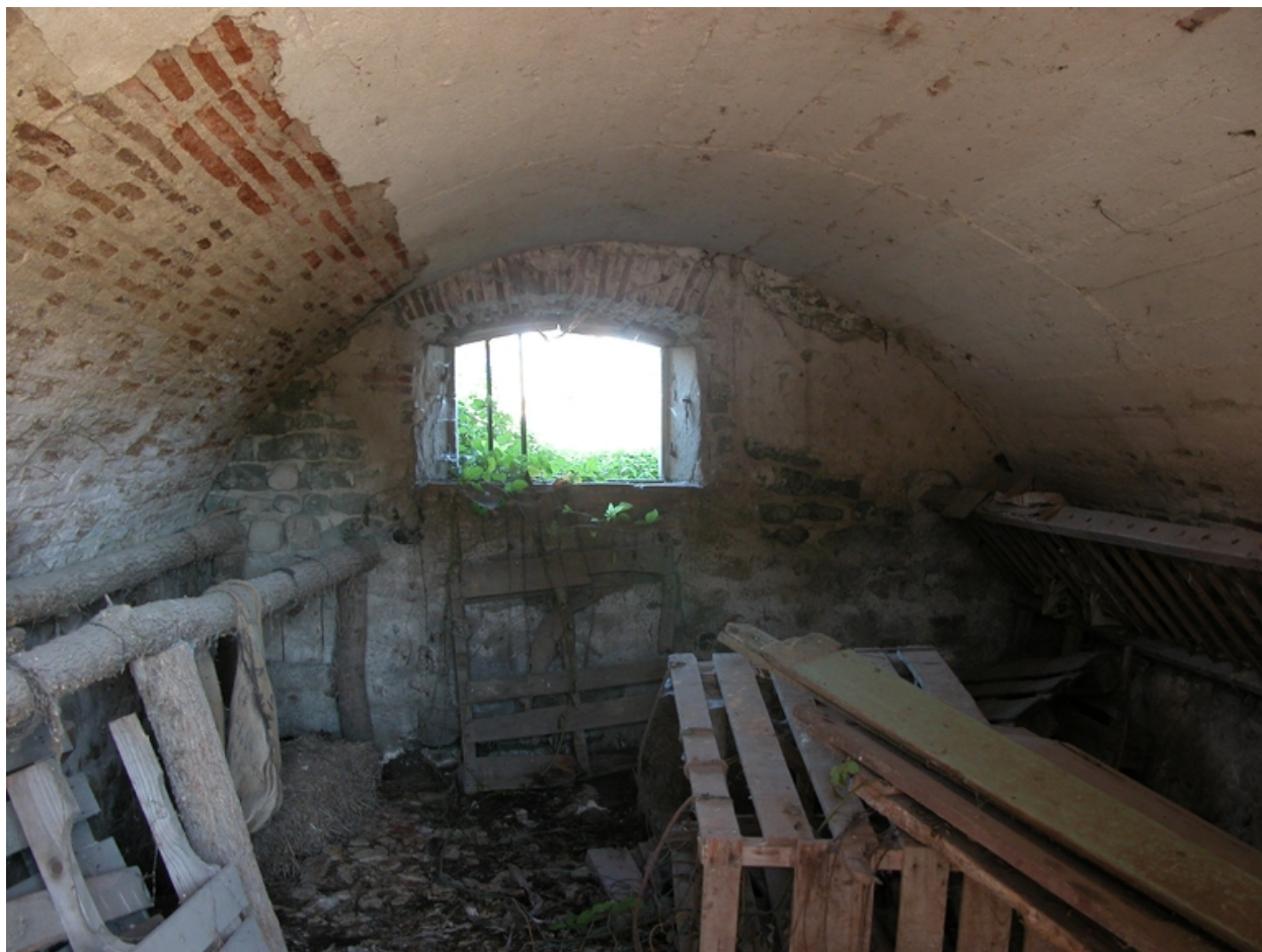
Vue intérieure du cellier : première cave.
