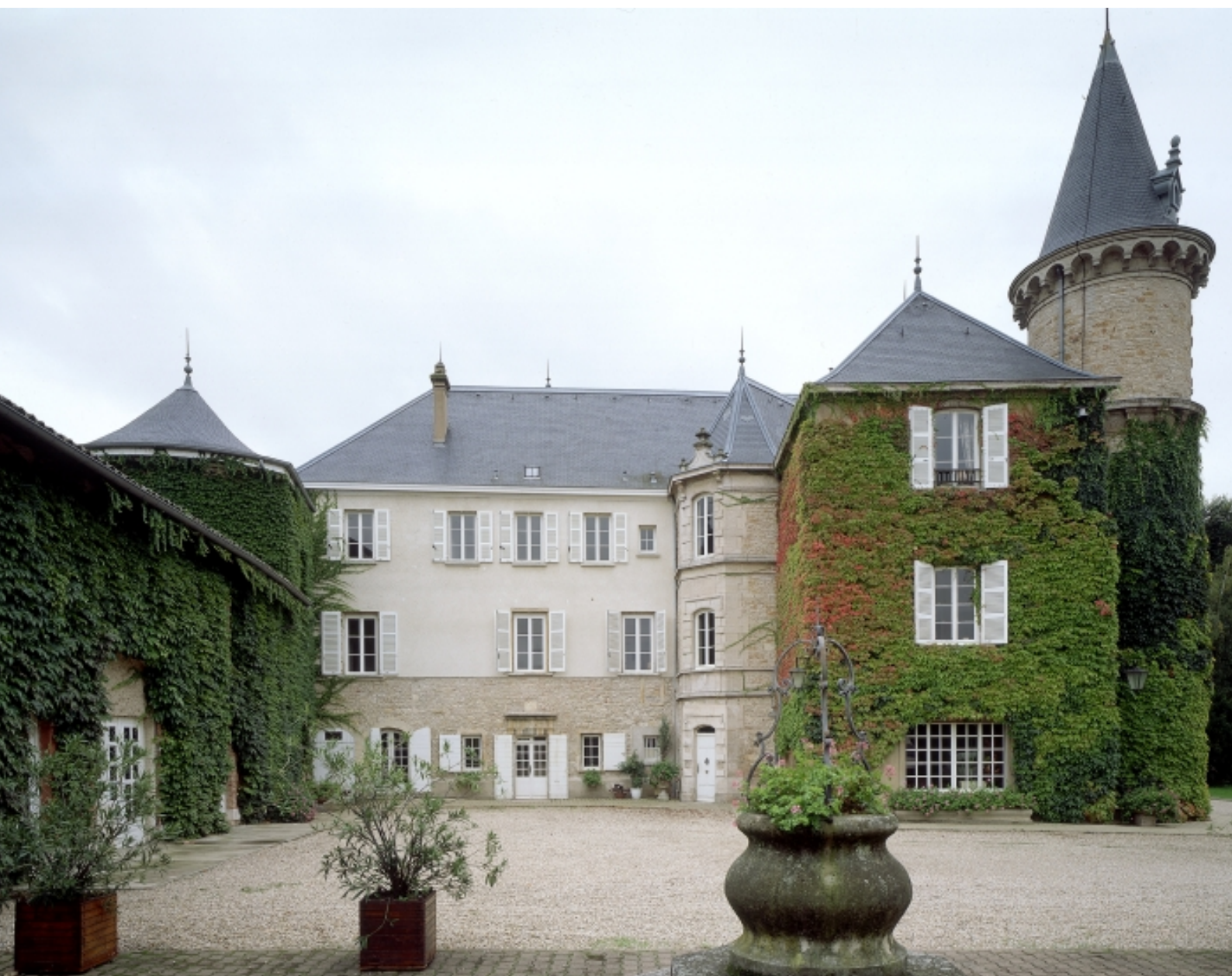
Façade sur cour.
