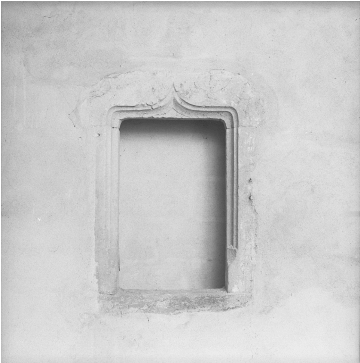
Baie avec linteau en accolade, sur cour intérieure.
