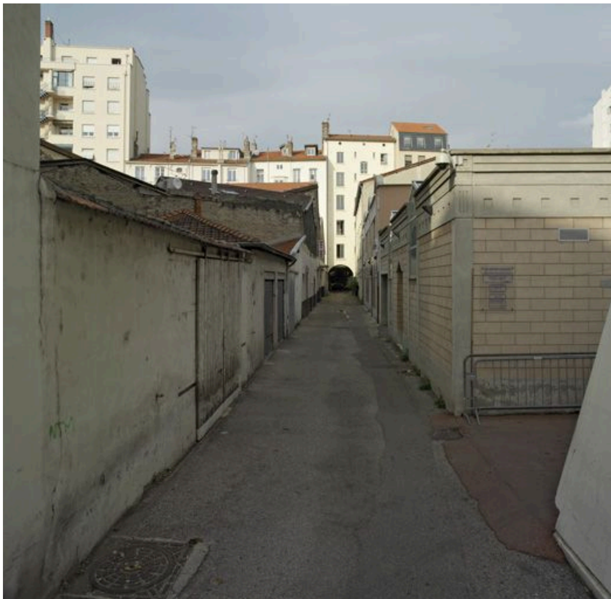
Le passage entre le cours Gambetta et la rue Rachais vu depuis le sud
