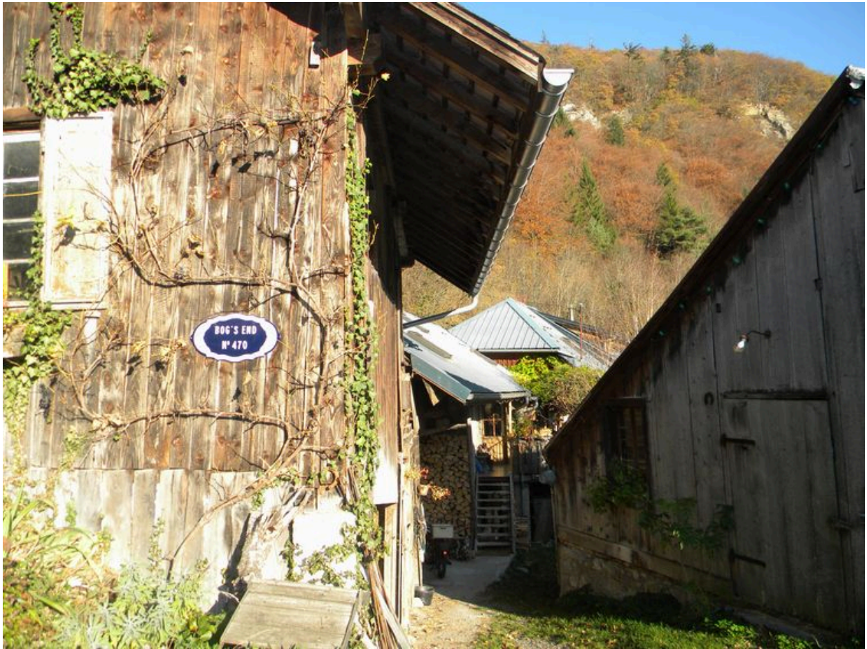
Vue du mur pignon ouest avec une partie de la façade sud en alignement.
