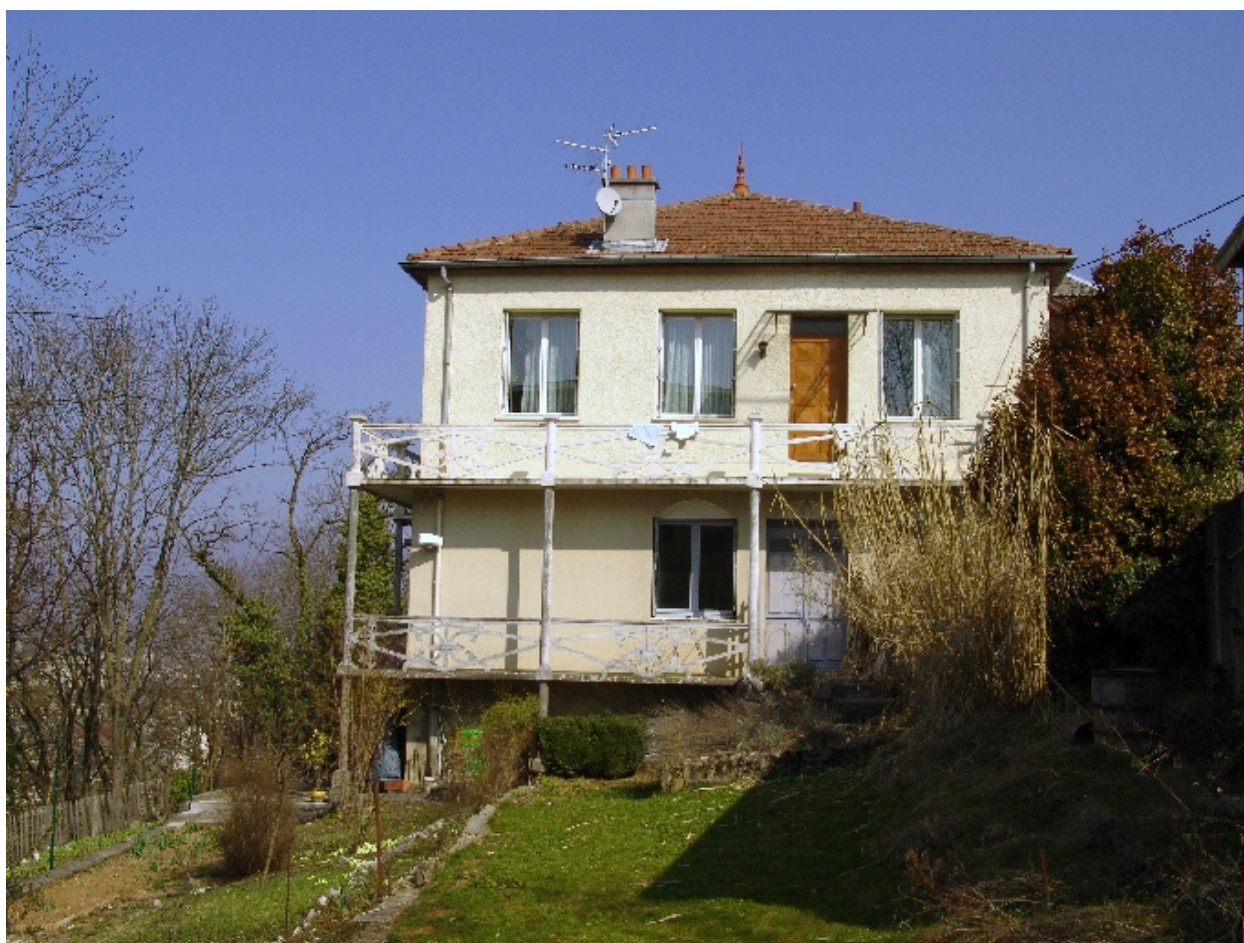
Façade latérale gauche
