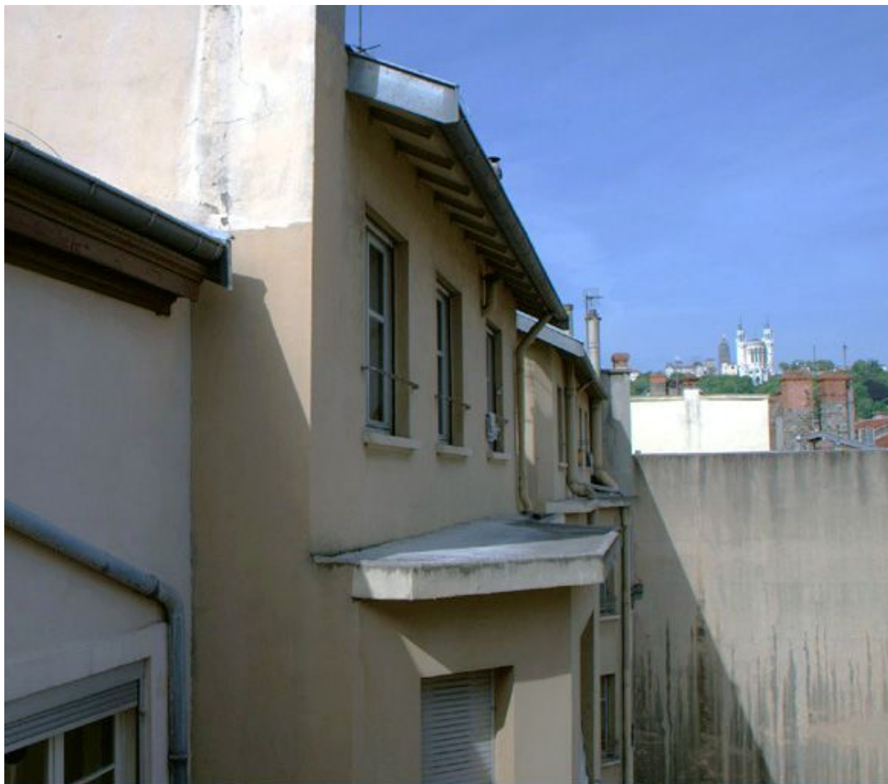
Elévation postérieure, détail
