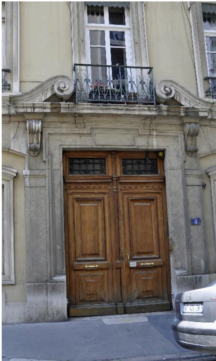
Vue rapprochée de la porte principale
