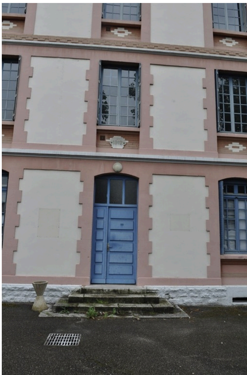
Bâtiment daté de 1912, travée centrale façade est.
