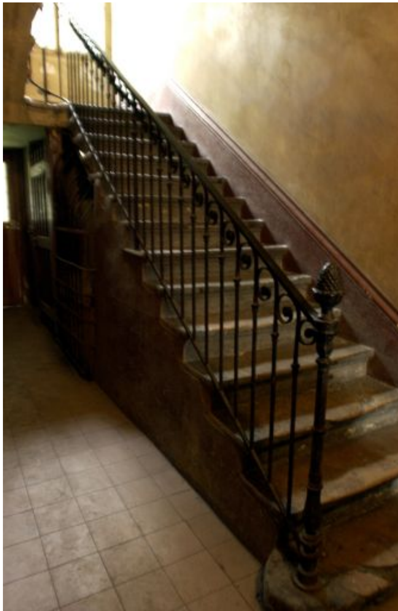
Vue de la montée d'escalier
