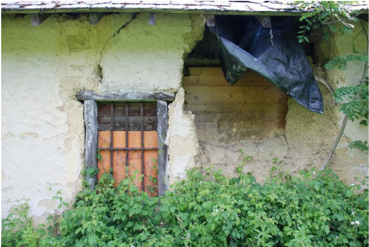
Détail d'ouvertures : mur nord.
