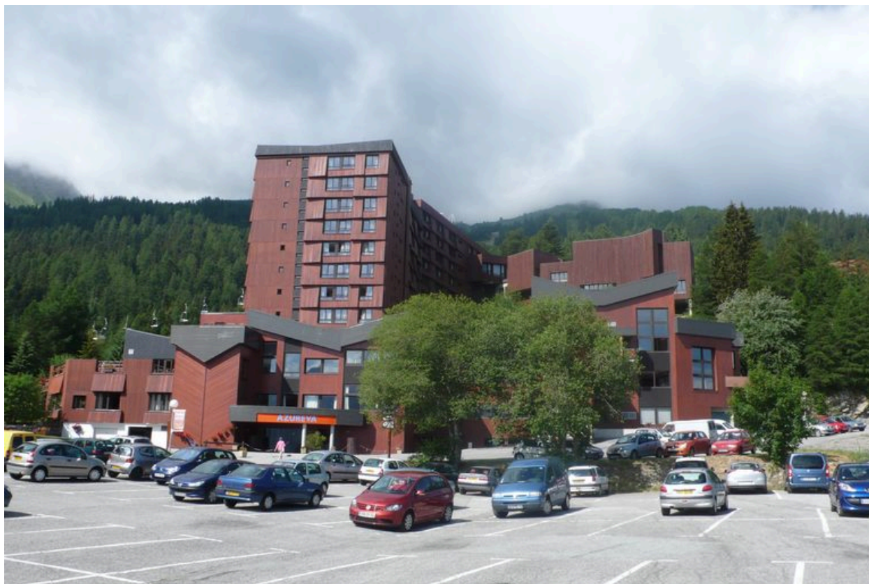
Vue générale depuis l'est
