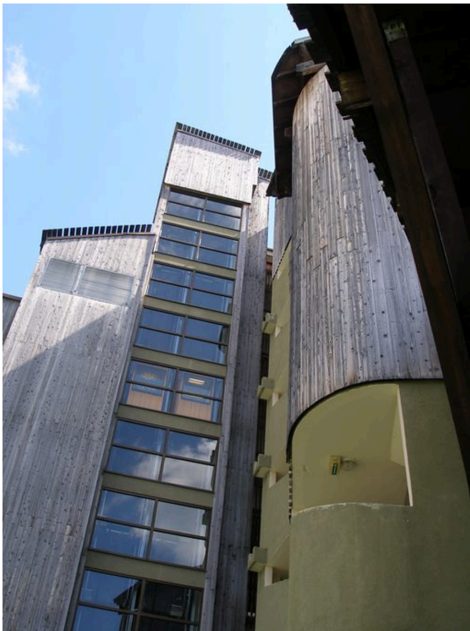
Les cages d'ascenseur et d'escalier
