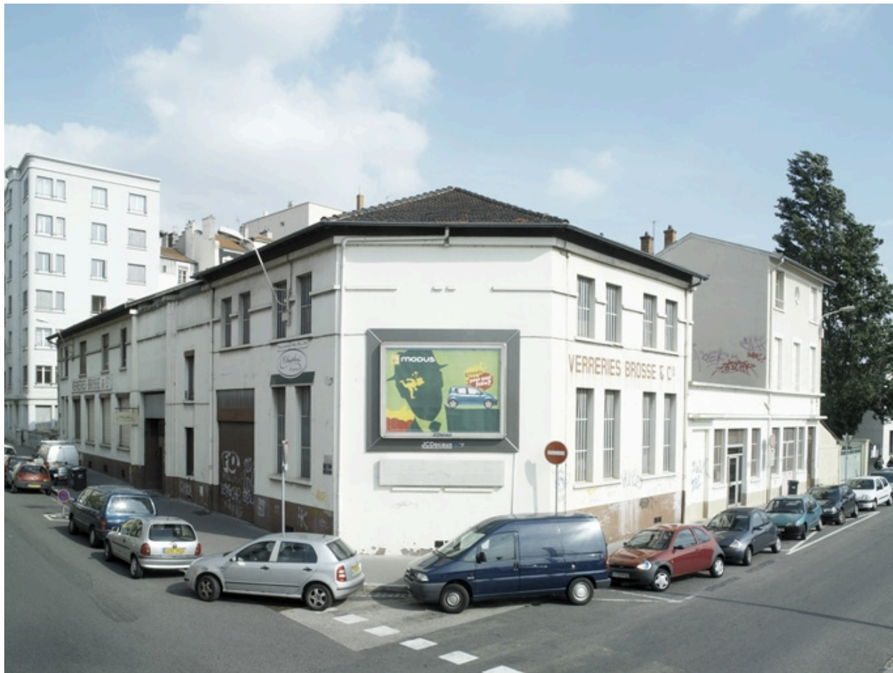
Vue d'ensemble sud-ouest, immeuble d'angle extension des années 1950
