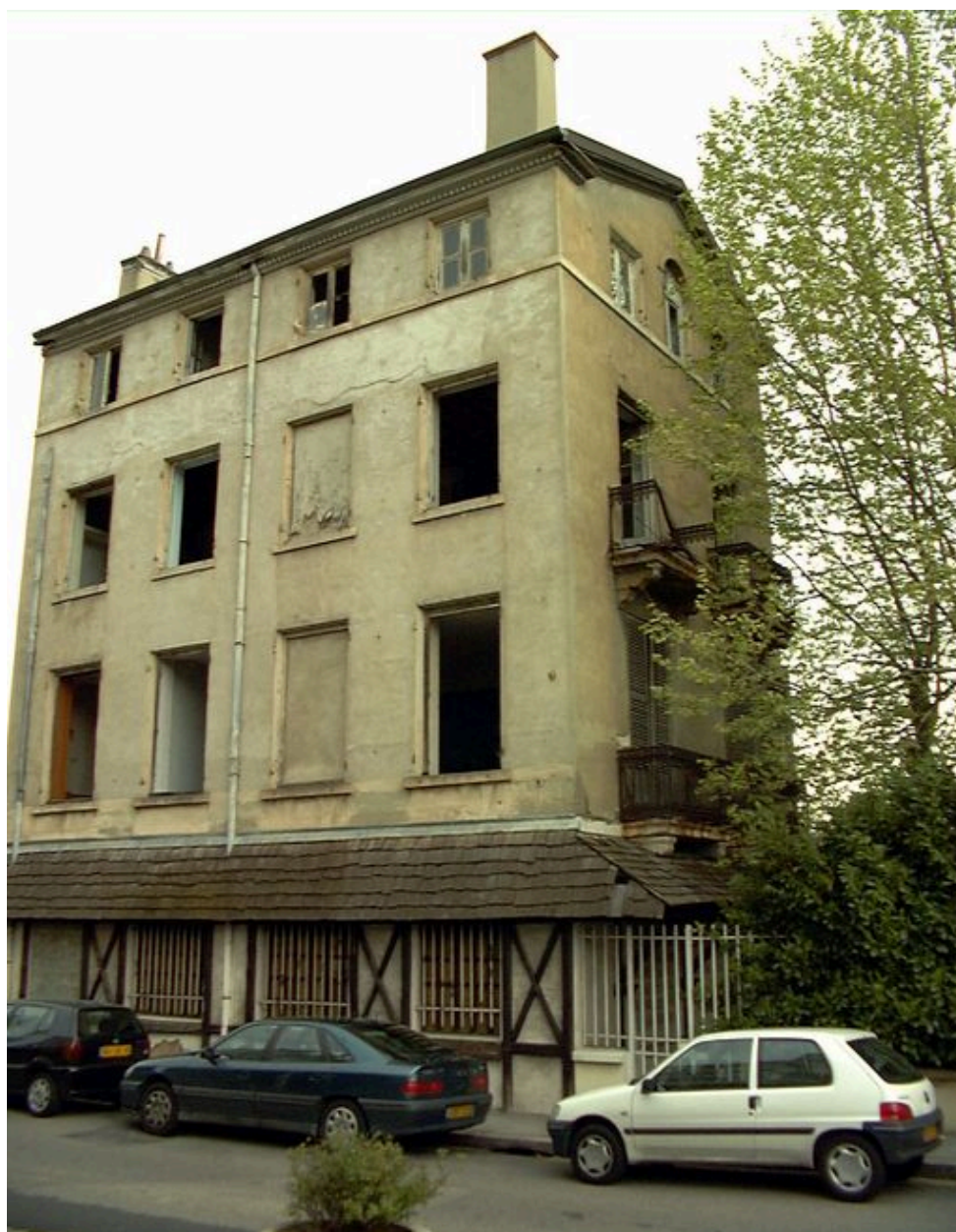
Elévations sud et est depuis le 2 quai du Commerce
