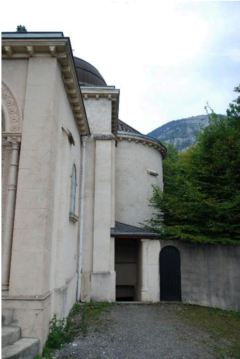
Vue d'ensemble de l'escalier latéral conduisant à la chapelle basse
