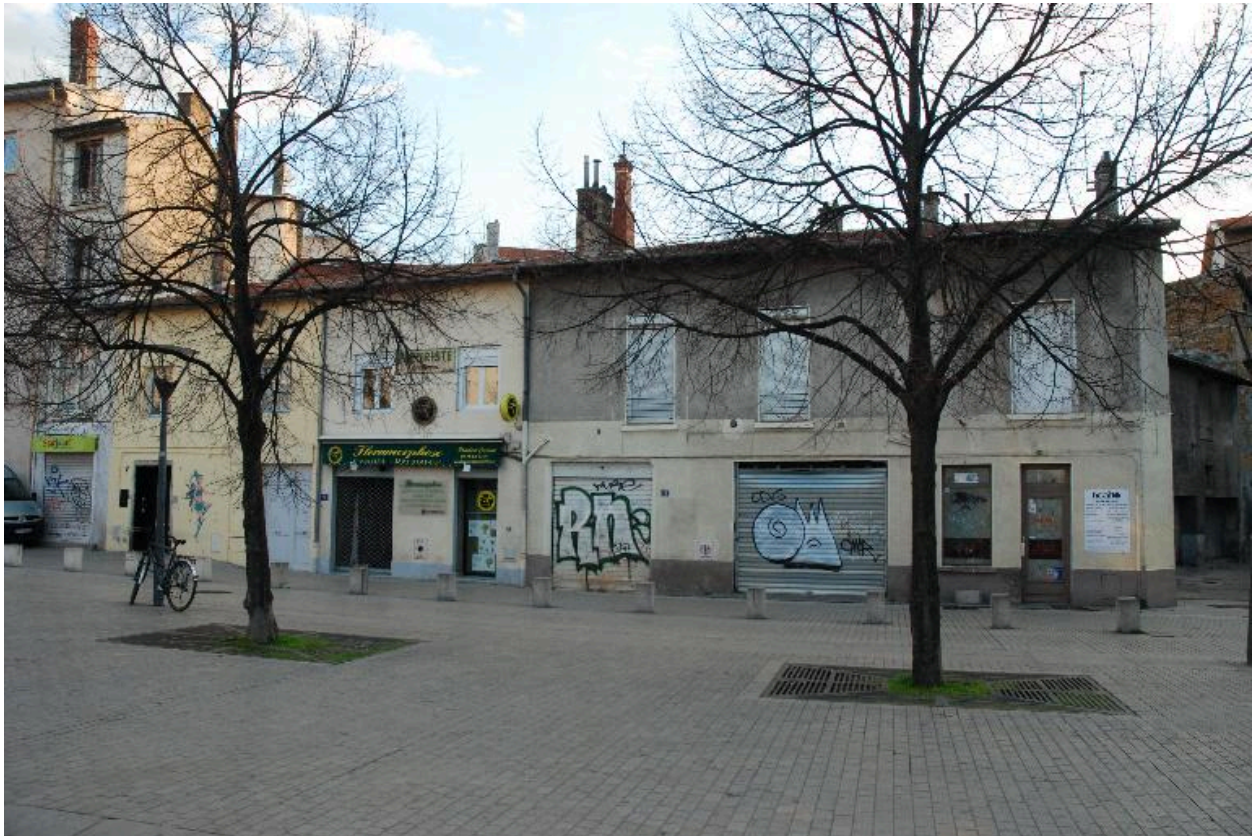
Vue d'ensemble des maisons Cointeraux
