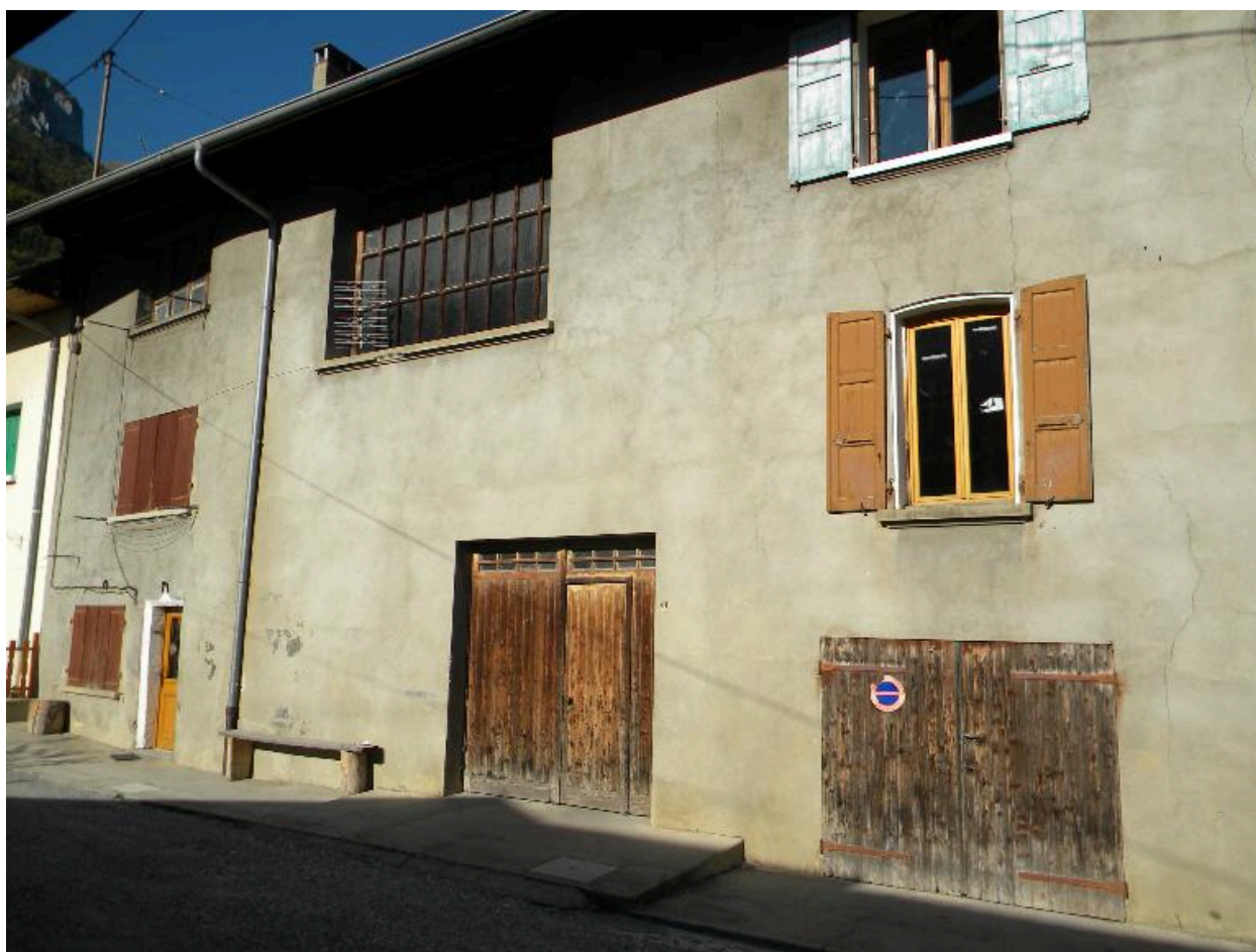
Vue de la façade sud.
