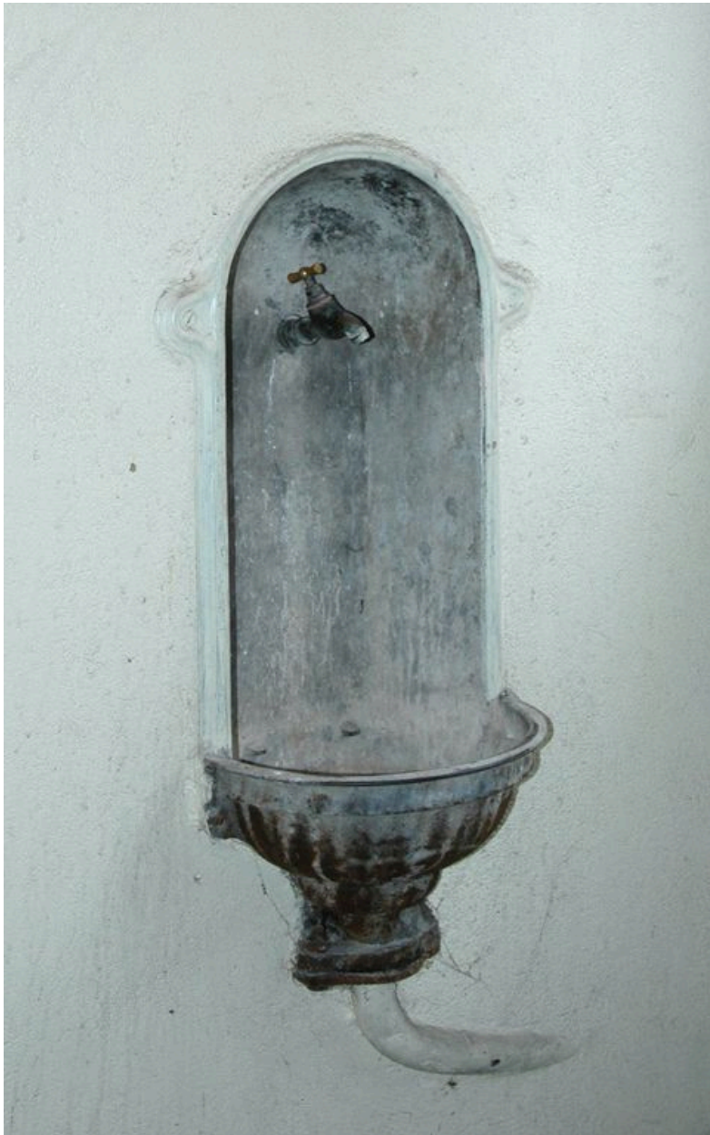
Fontaine située sur le mur sud du repos de chaque palier
