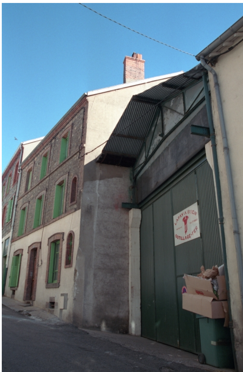
Boën, îlot 13, Ph. Raymond (rue) 16, 18. Vue générale des façades sur rue.
