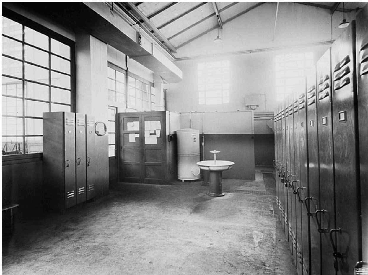
Vestiaire localisé dans la connexe au hall mécanique (1957)
