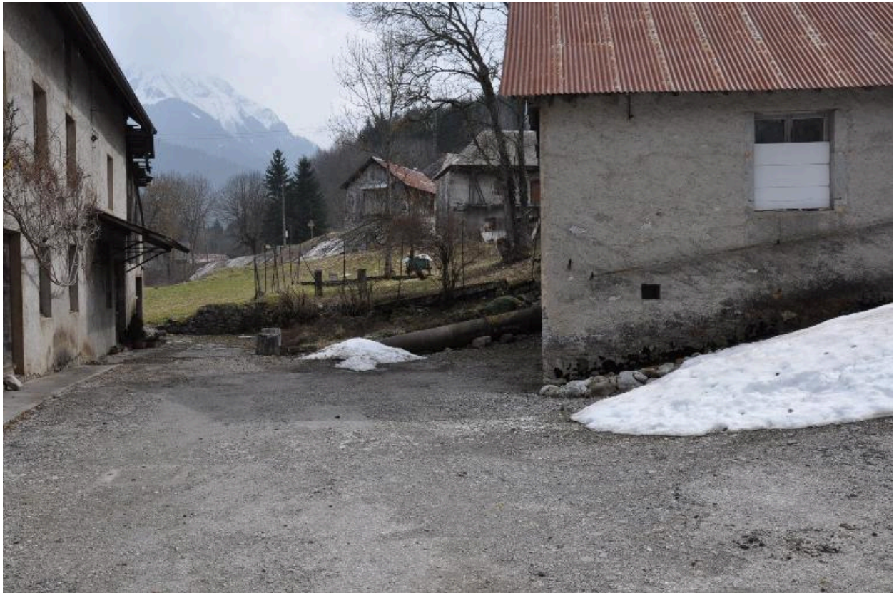
Vue de la conduite forcée.
