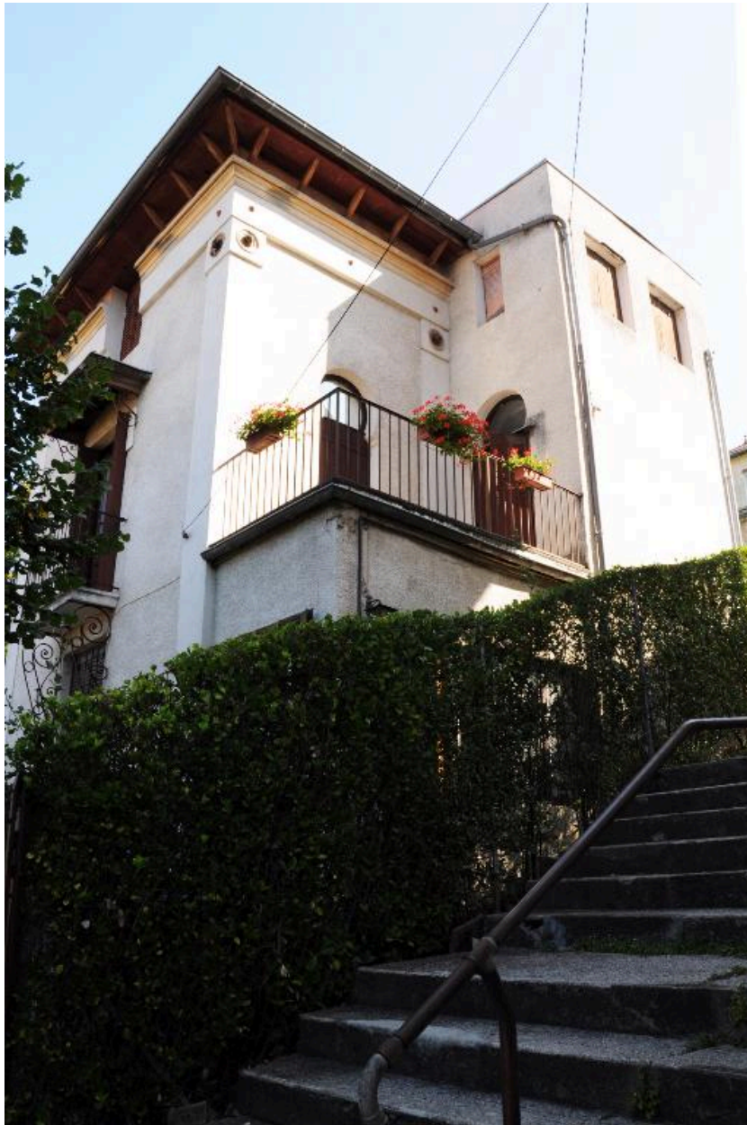
Façade principale orientée à l'ouest, vue de trois-quart depuis le sud-ouest
