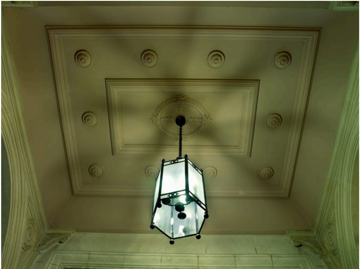
Vue de la lanterne du hall d'entrée.
