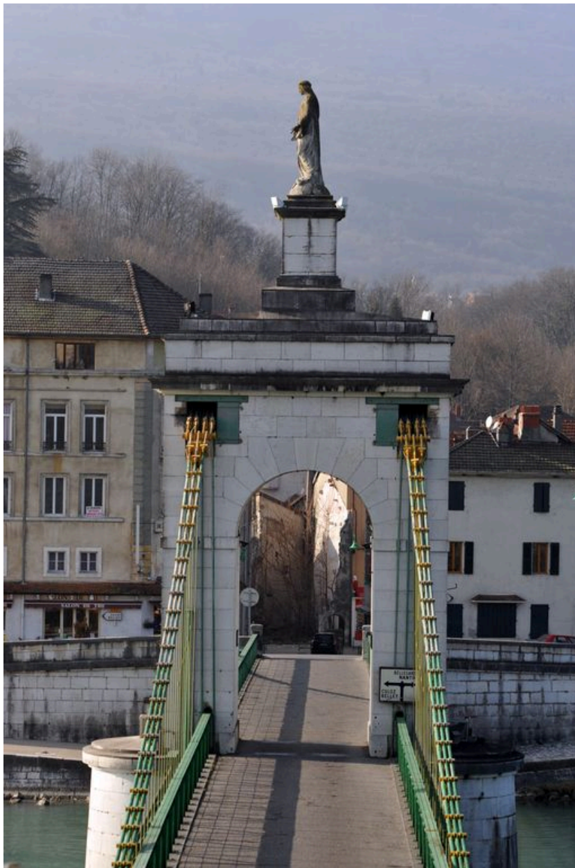
Pile centrale, vue partielle (depuis la rive gauche)
