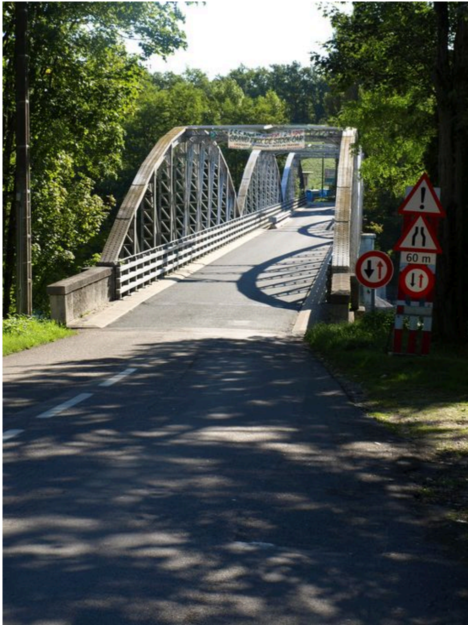
Vue générale, de dessus, chaussée (depuis la rive droite)
