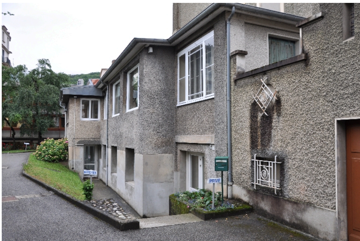
Façade nord du siège social
