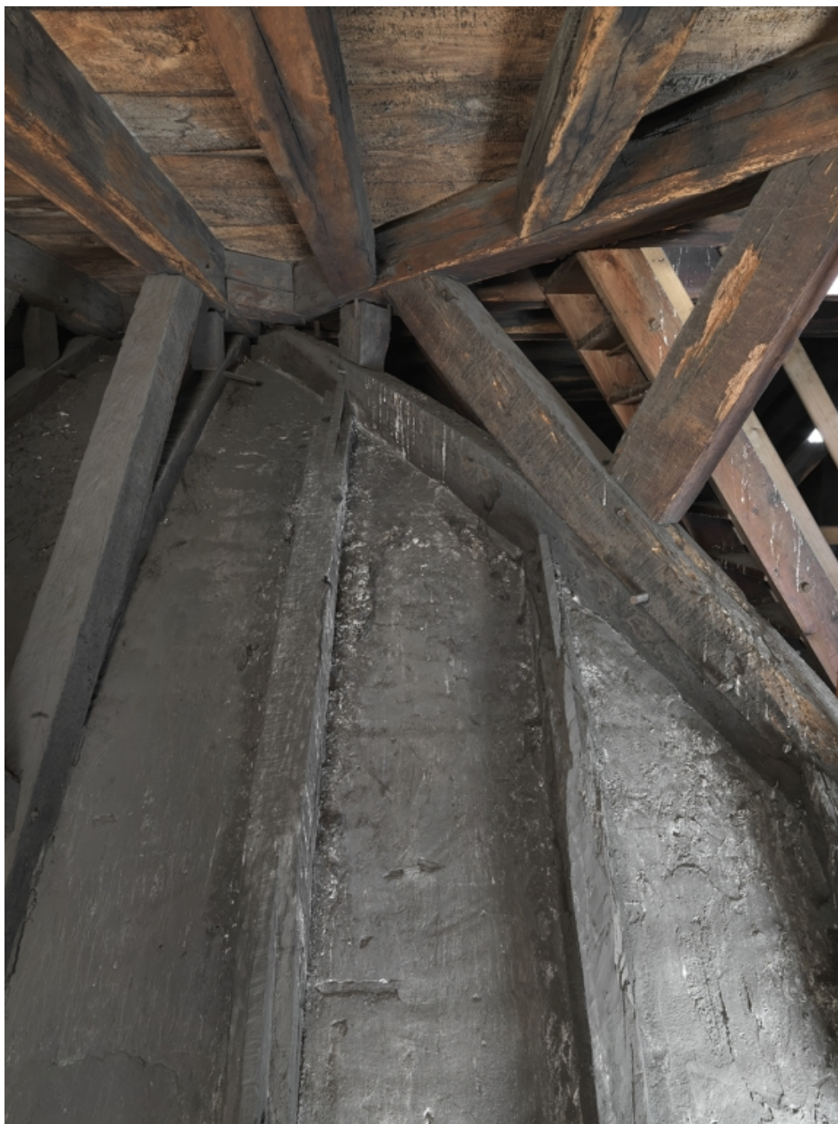
Le dôme des Quatre Rangs. 1er niveau de charpente. L'arbalétrier du dôme intérieur et la charpente supportant le plancher du 2e étage
