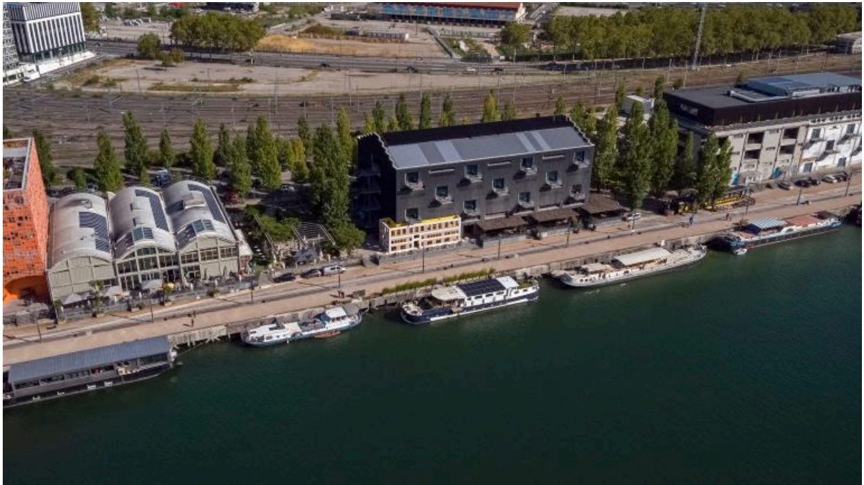
Vue d'ensemble du pavillon des douanes, des sels du port Rambaud après reconversion (drône)
