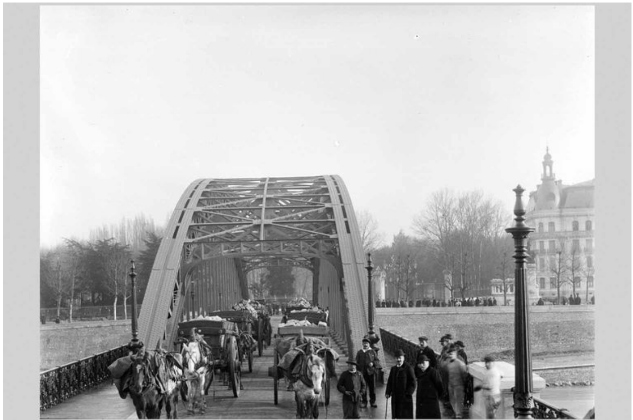
La construction du pont de la Boucle. L'épreuve de charge. Photogr., [1903] (Arch. mun. Lyon. 15 Ph 1836)
