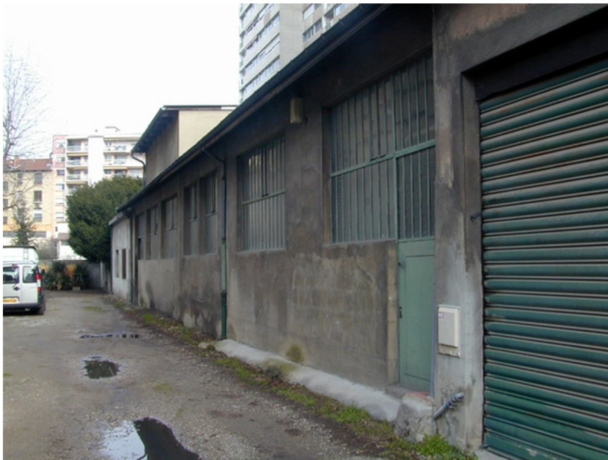
Vue générale de l'atelier impasse Dubois à Villeurbanne
